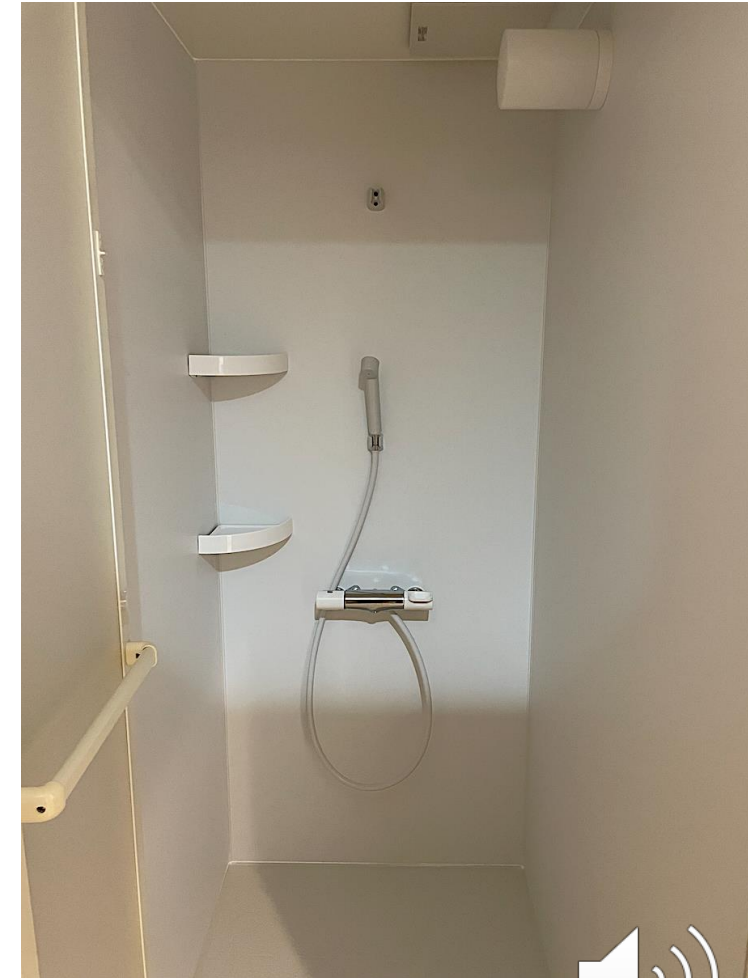
改修後（専用のシャワーブースを設置）
